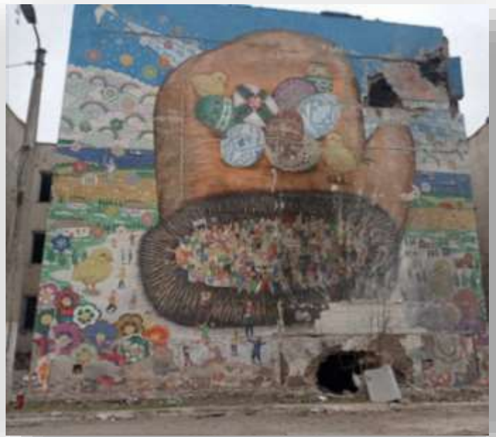
砲撃を受けて壁の一部が崩れ落ちている 2022年4月
