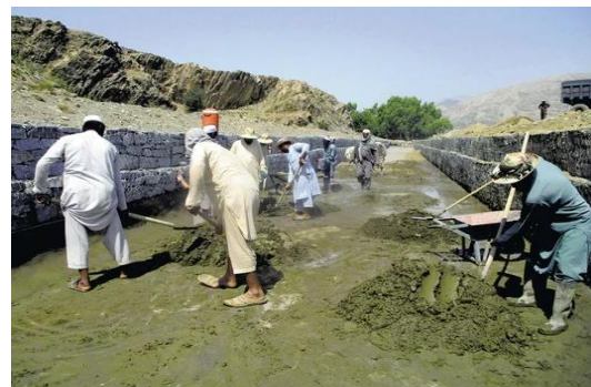
用水路の建設工事を行う現地の作業員たち
