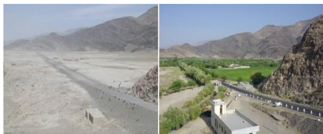
用水路の完成前(左)と完成後(右) アフガン東部
